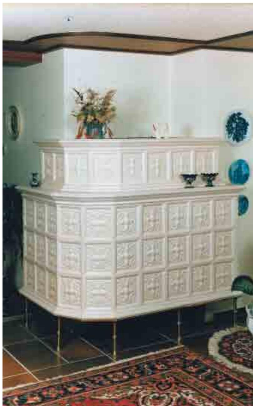
На развороте печи, облицованные рельефным стиливым кафелем (Зайффарт): на печи слева кафель не стандартного размера (24x27), печь справа в кафеле стандартного размера (22x22).
