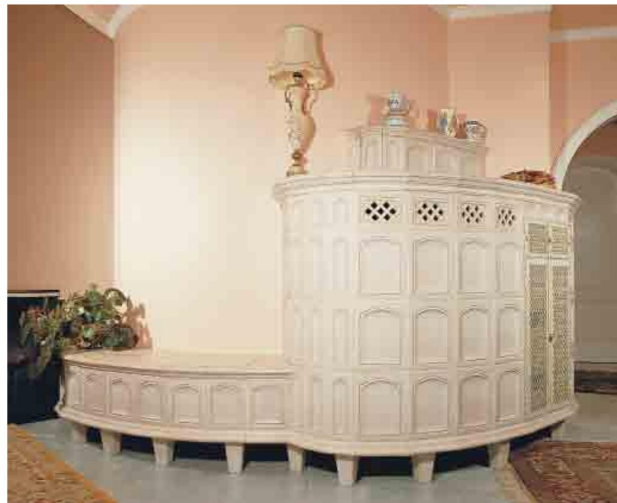
Наверху большая теплонакопительная кафельная печь на ножках с нагреваемой скамейкой (Зайффарт). Печь очень удачно расположена в помещении по периметру круглого выступа. Хайцбруст печи (топочная и зольниковая дверцы в одном блоке) закрыт декоративным фортюром.
